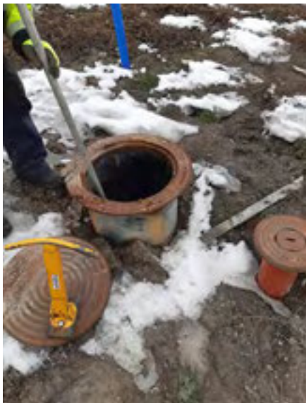
Vuove-Insinöörit Oy teki huhtikuussa 2023 vuotovesimittauksia Haminan jätevesiviemäriverkostossa.
